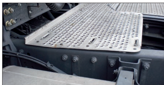
Laufsteg geringfügige Verformung
