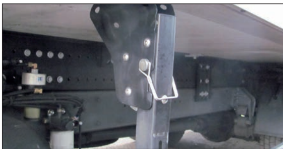
Halterung Seitenanfahrtschutz verbogen
