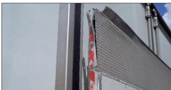
Anfahrsschaden Anbauteile (LBW)
